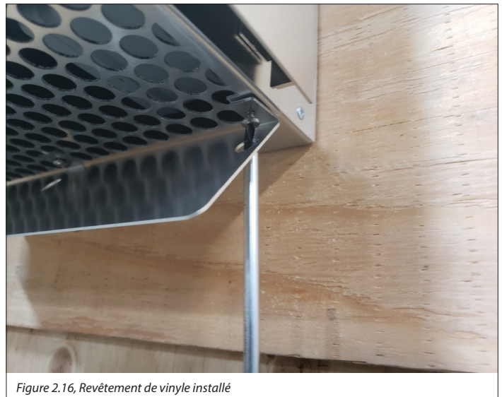
Figure 2.16, Revêtement de vinyle installé
