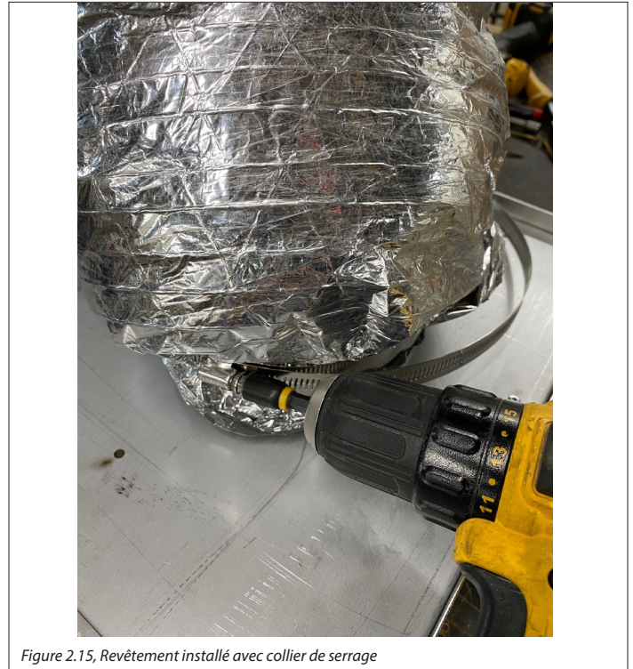
Figure 2.15, Revêtement installé avec collier de serrage
