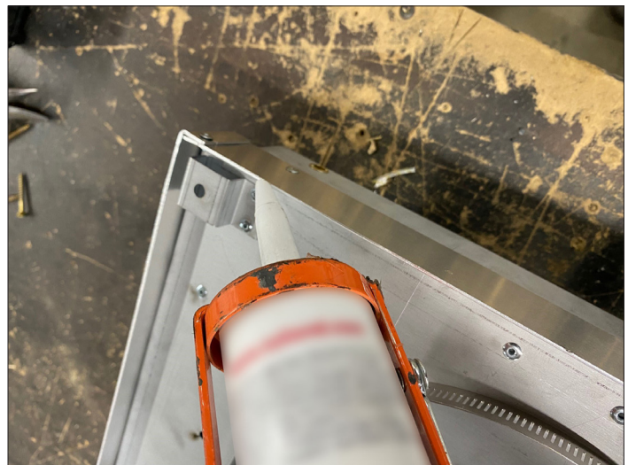
Figure 2.8, Appliquez le scellant silicone sur la face arrière du HTK-EXT
