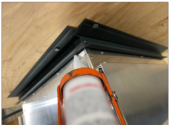
Figure 2.9, Appliquez le scellant silicone sur les matériaux de finition
