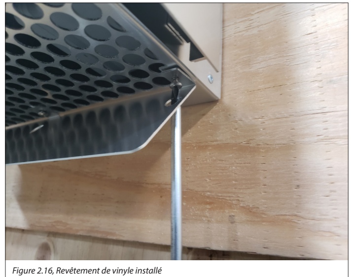
Figure 2.16, Revêtement de vinyle installé
