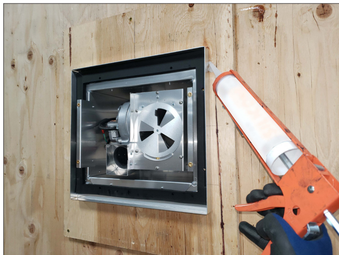
Figure 3.20, Silicone autour de la base du chapeau
