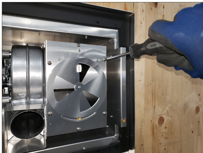
Figure 5.2, Vis de l'évacuateur
