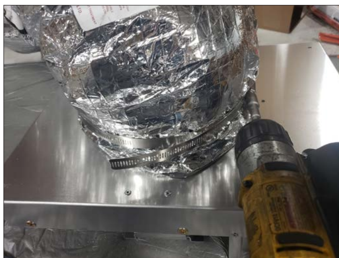
Figure 2.17, Revêtement installé avec collier de serrage
