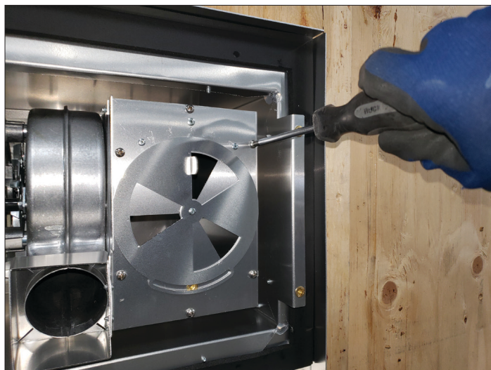
Figure 5.2, Vis de l'évacuateur
