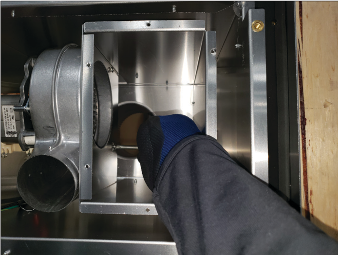
Figure 5.6, Retrait des (3) vis de fixation du ventilateur
